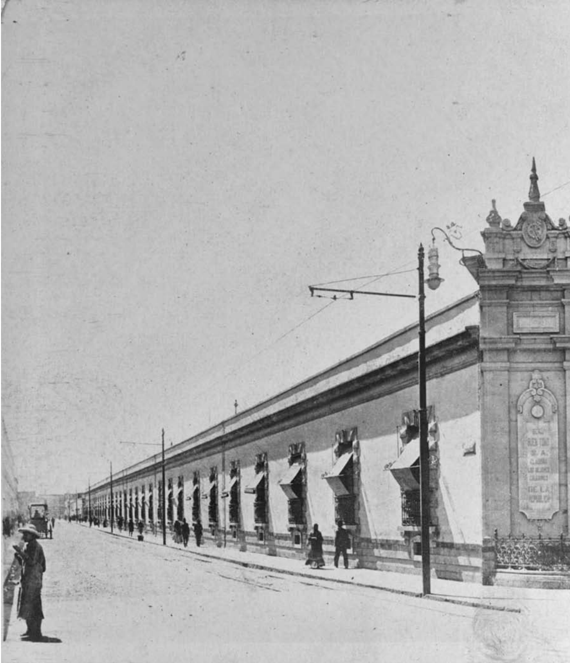
Fachada de la fabrica de cigarro EL BUEN TONO S.A. cuyo principal
