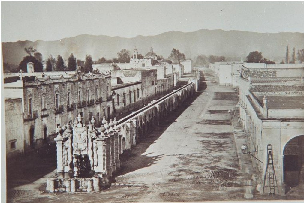
Fuente del salto del agua, culminación del acueducto de más de cuatro kilómetros que venía desde Chapultepec, c.1872.
