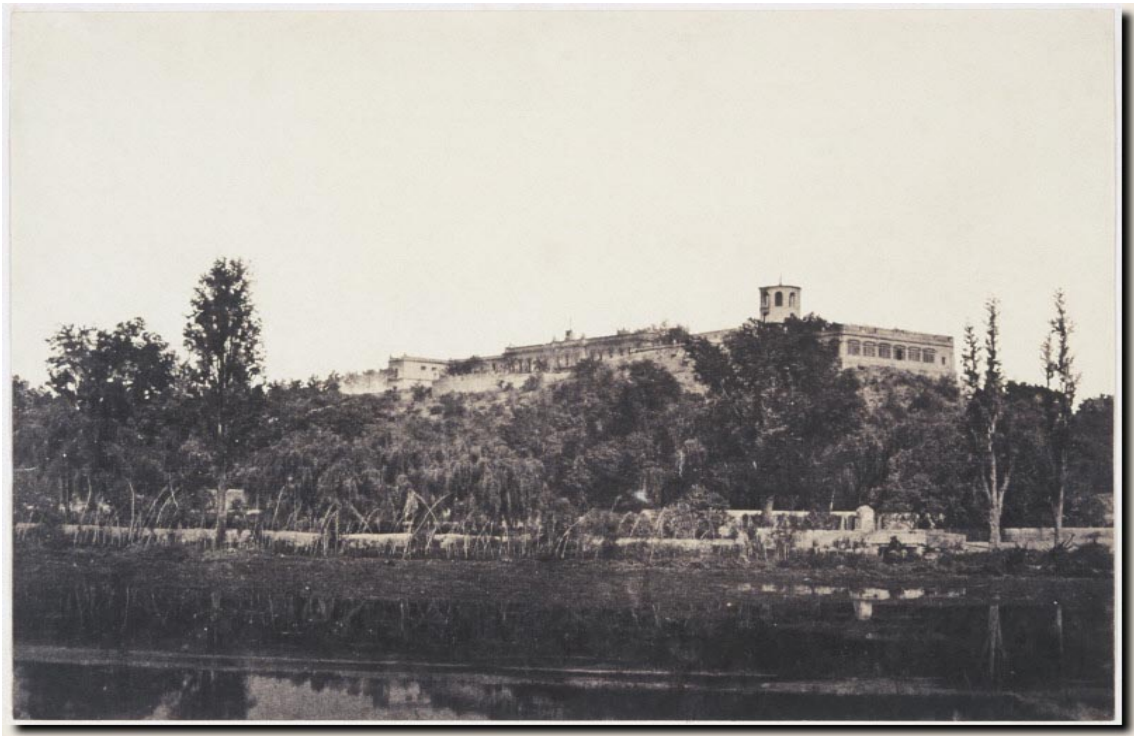
Le château de Chapultepec. En premier plan le lac puis l'aqueduc qui arrivait jusqu'à la fontaine del « Salto del Agua ».
